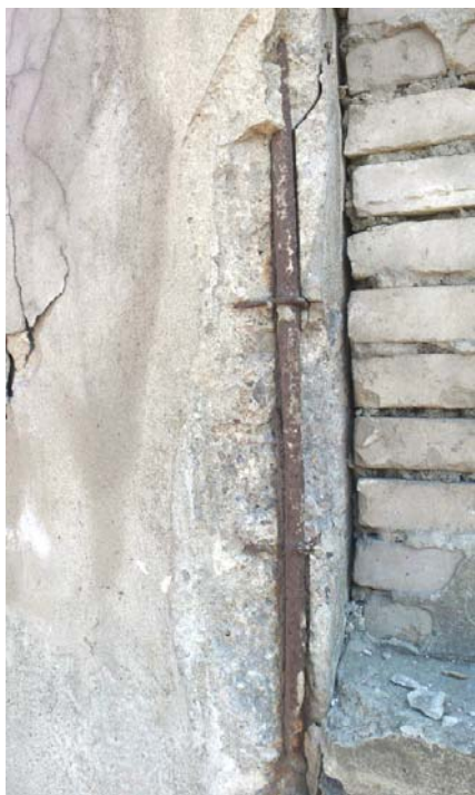
Foto 46 Noblessneri tehase laevasüsteemidetsehhi karkassiposti roostetav sarrus Autori foto, 2009
