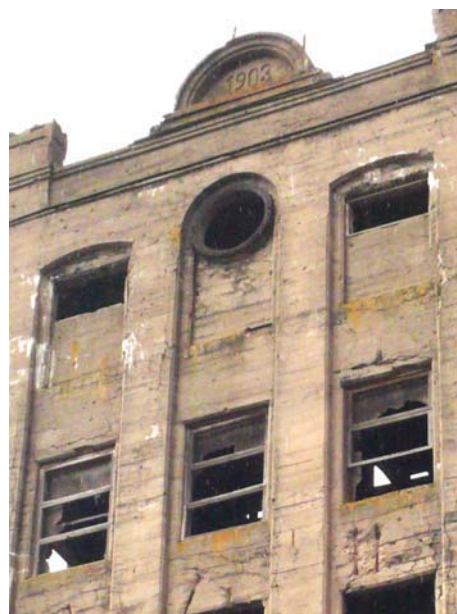
Foto 20 Sindi kalevivabriku kella- ja veetorn Autori foto, 2008
