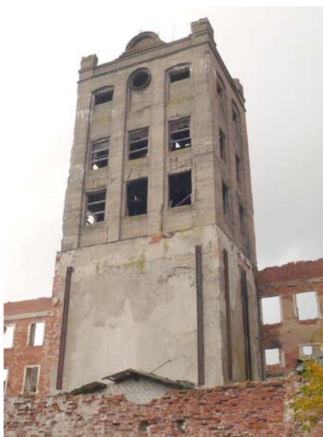
Foto 19 Sindi kalevivabriku kella- ja veetorn Autori foto, 2008
